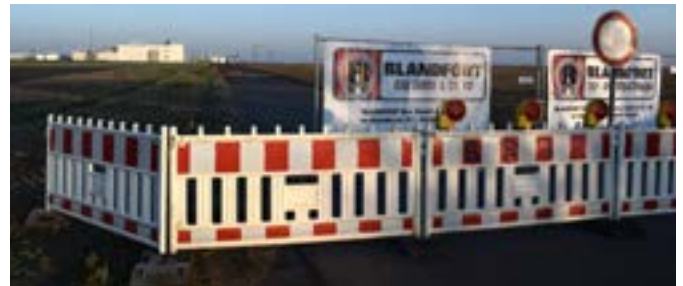
Der Wirtschaftsweg zwischen dem Zülpicher Gewerbegebiet „An der Römerallee“ und der Landesstraße 162 bei Nemmenich wird in den kommenden Monaten zu einer vollwertigen, öffentlichen Straße ausgebaut. Foto: Stadt Zülpich / Torsten Beulen
